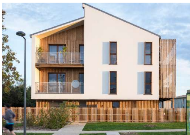
TERRALIA (Groupe ESSIA). Woodway, à Chanteloup-En-Brie (77), 62 logements. Architecte : Cabinet Séméio. Crédit photo : Sergio-Grazia.
