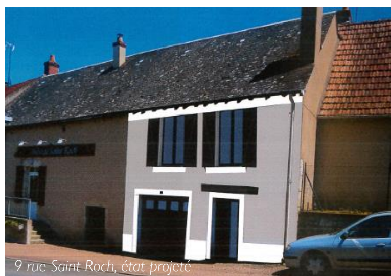
9 rue Saint Roch, avant travaux
