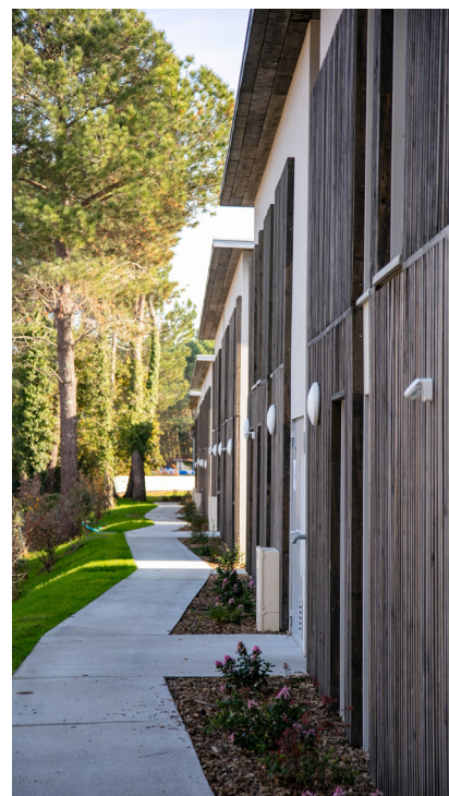
LE COL. Résidence DUNAVERDE, à CAPBRETON (40), livrée en septembre 2021. 42 Logements en BRS. Crédit photo : Patrick VALLEAU. Architecte : Serge HIQUET Architect D.P.L.G
